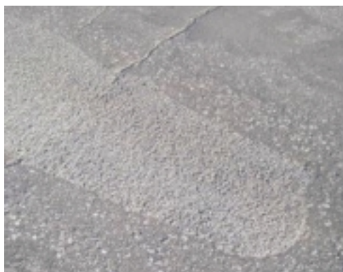
>>> Вид поверхности покрытия с МАК-смесью, уложенной в колею для ее выравнивания, - ноябрь 2004 года
