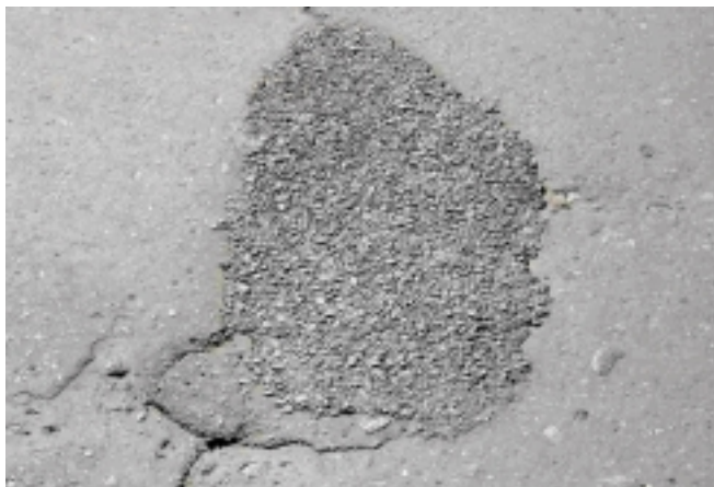
>>> Вид поверхности покрытия с МАК-смесью, уложенной при ямочном ремонте без разделки карт
