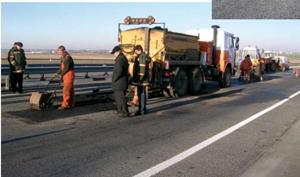
Магистраль М1. Белоруссия. Ремонт картами. Машина с дозированной выгрузкой холодной смеси
