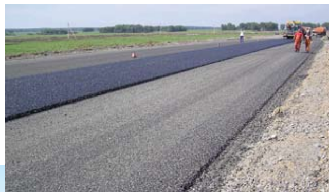
Новосибирская область. Реконструкция дороги с применением холодной смеси
